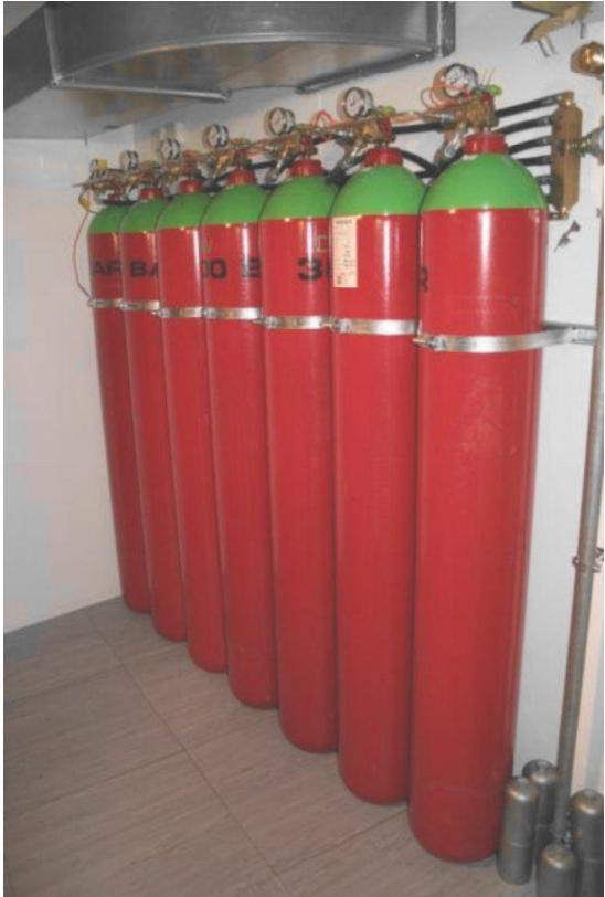
При несанкционированном срабатывании установки газового пожаротушения с инертными газами процентное содержание кислорода в атмосфере защищаемого помещения уменьшается до 11,5% и у человека возникает асфиксия (удушение) со 100% летальным исходом.
